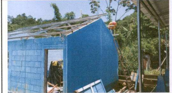
Foto 2: Sustitución de estructura de madera por metal.
