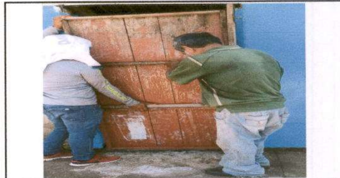
Foto 6: Cambio de puertas y techo de servicios sanitarios.
