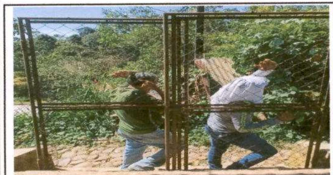
Foto 5: Cambio de portón de metal.
