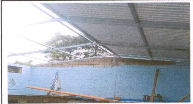
Foto 1: Sustitución de cubierta de lámina por lámina troquelada Aluzinc.
